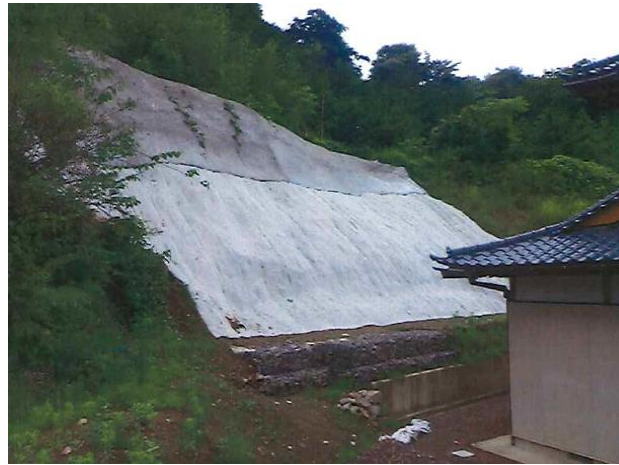
筆甫字下北山地区治山工事完了後の様子
