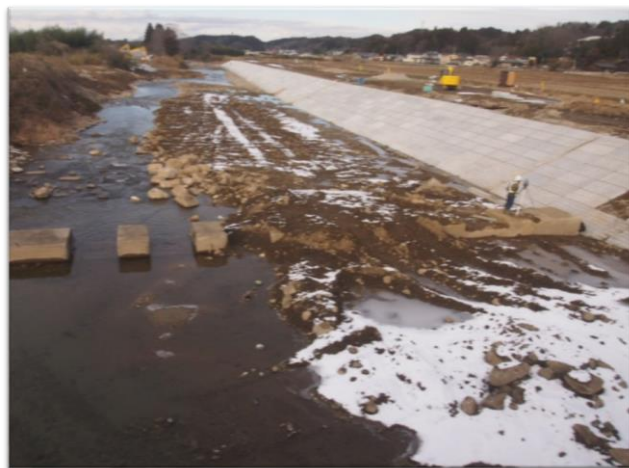
雫子尾川(大内字清水地先)復旧工事の様子
