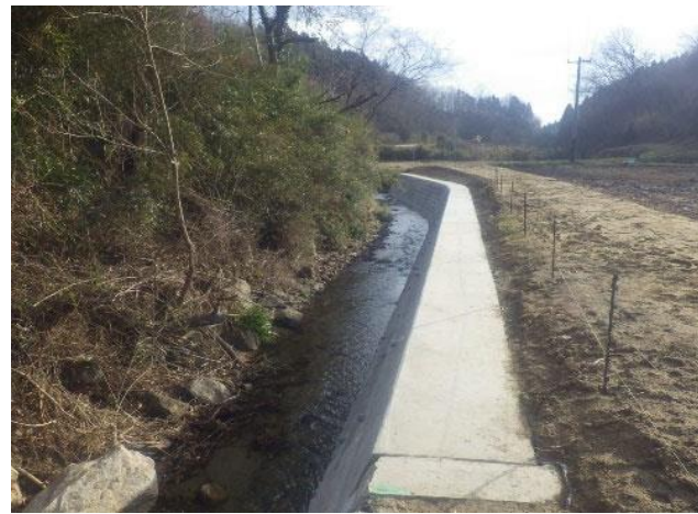
小田川(大張字大倉)復旧後の様子
