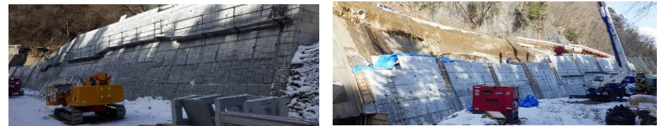
県道丸森霊山線復旧工事の様子
