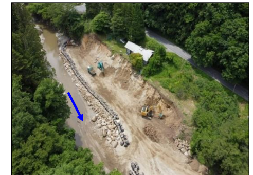
内川不動尊地区（護岸工事）の様子
