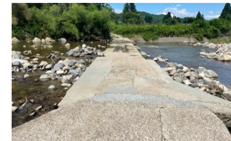
頭首工復旧後の様子(大内字石宇)
