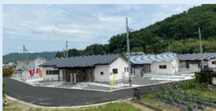
竹谷住宅(木造)完成後の様子
