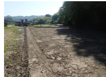
農地復旧後の様子(丸森町字五福谷)
