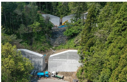
流路工事の様子(大張川張字槌屋)
