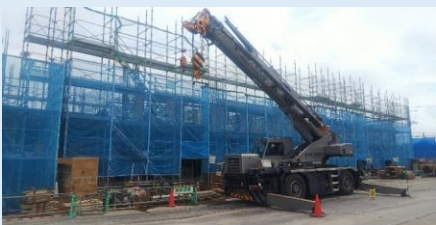
神明住宅(RC造)躯体工事の様子
