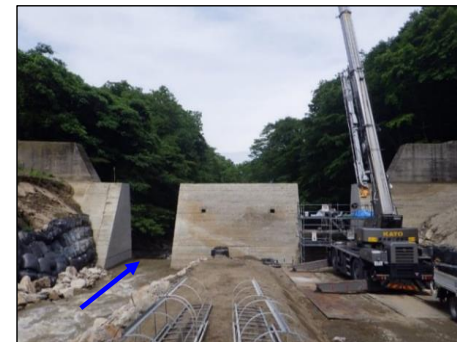
内川(東山砂防堰堤工事)の様子
