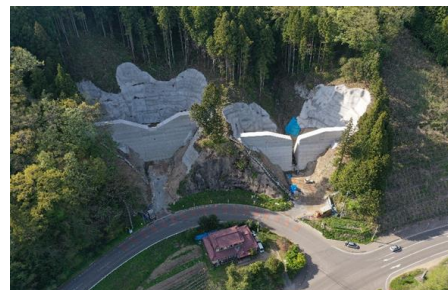
堰堤背面人工地山工事の様子(大張川張字片倉)
