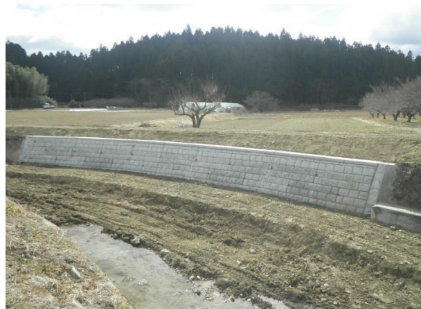
芳ヶ沢川(大内字北伊手)復旧後の様子
