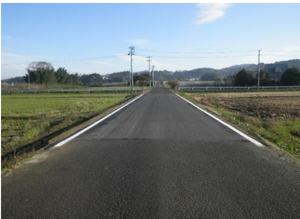
七夕新桜町線(大内字松沢)復旧後の様子
