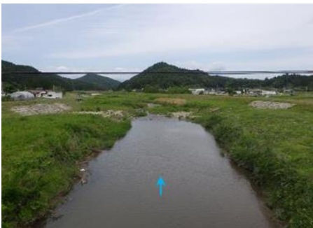
雫子尾川河道掘削実施予定箇所(金山字石神)
