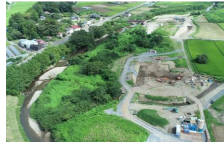
中平橋下流左岸樋門工事の様子(大内字中平)
