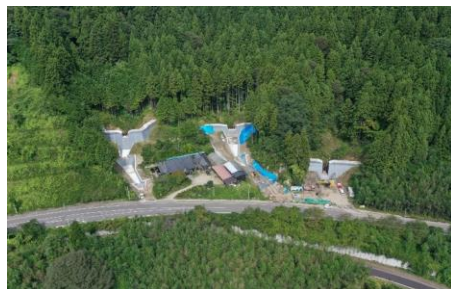
砂防堰堤流路工事の様子(大張川張字片倉)
