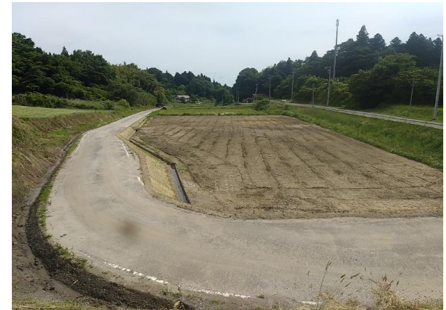
農地復旧後の様子(丸森町字羽出庭)
