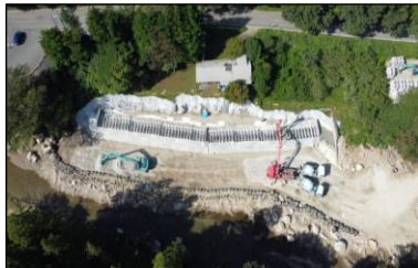
内川護岸工事の様子(丸森町字不動)
