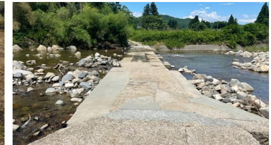
頭首工復旧後の様子(丸森町字石宇)
