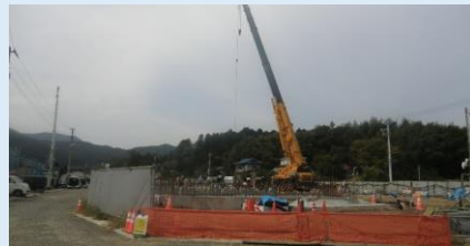
神明北住宅(RC造)躯体工事の様子
