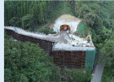
③ トンネル坑口部擁壁施工中
