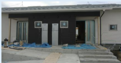
神明住宅(木造)建設工事の様子
