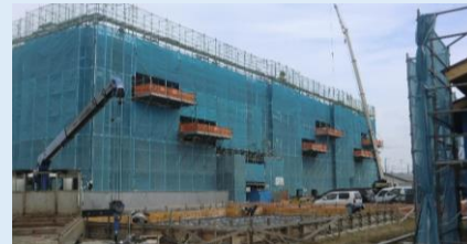
神明住宅(RC造)建設工事の様子
