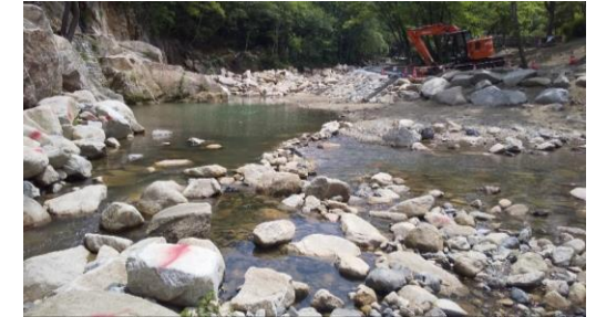
頭首工実施予定箇所(丸森町字不動)
