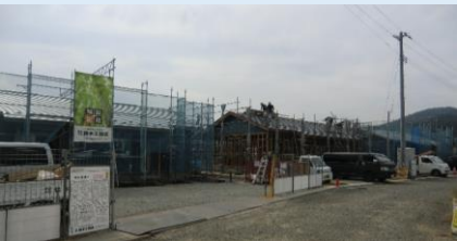
神明北住宅(木造)建設工事の様子
