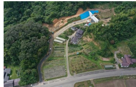
砂防堰堤流路工事の様子(館矢間山田字永作)
