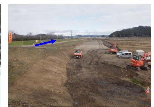
新川盛土工事の様子〈丸森町字土橋〉
