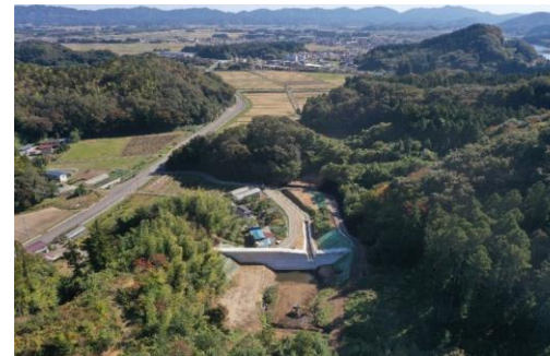
砂防堰堤完成後の様子(館矢間山田字永作)
