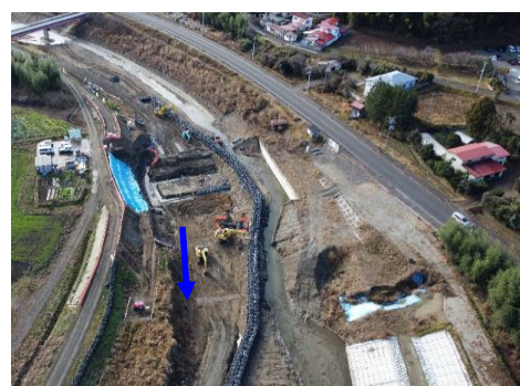
和田堰工事の様子（丸森町字上林南）
