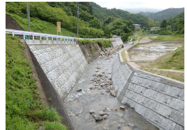
芦沢川復旧後の様子（耕野字火石坂）
