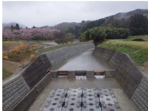
桜淵川復旧後の様子（丸森町字石羽）
