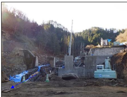
砂防堰堤工事（改築）の様子（丸森町字薄平）
