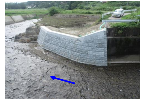
内川護岸工事完成後の様子〈筆甫字中下〉
