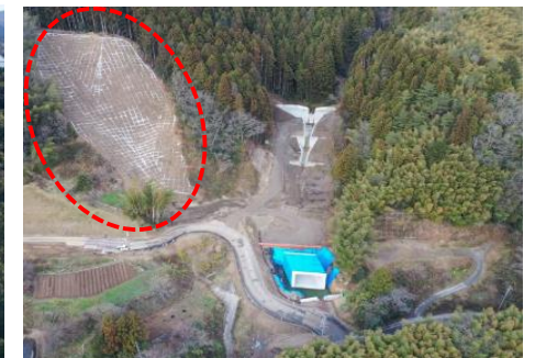
法枠工完成後の様子(耕野字沼)
