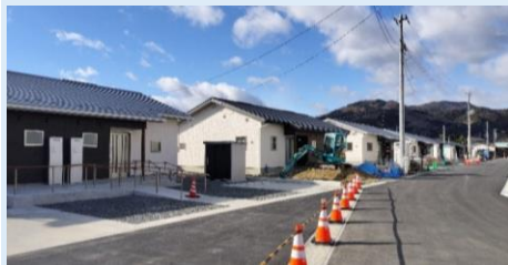
神明北住宅(木造)建設工事の様子
