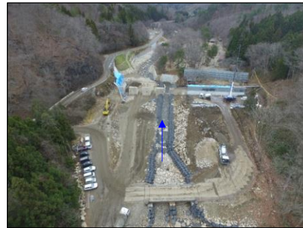
砂防堰堤工事（改築）の様子（丸森町字不動）
