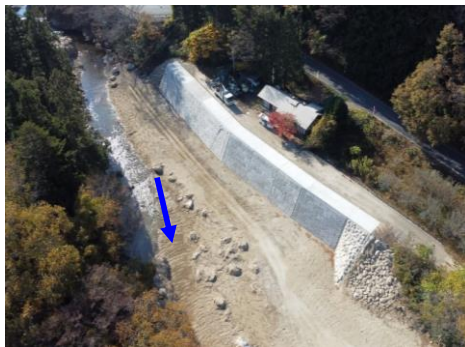
内川護岸工事完成後の様子〈丸森町字不動〉
