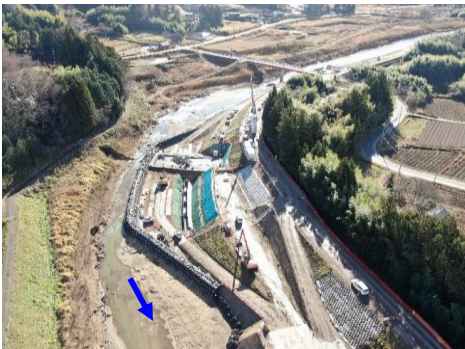
山下堰工事の様子（丸森町字上林東）
