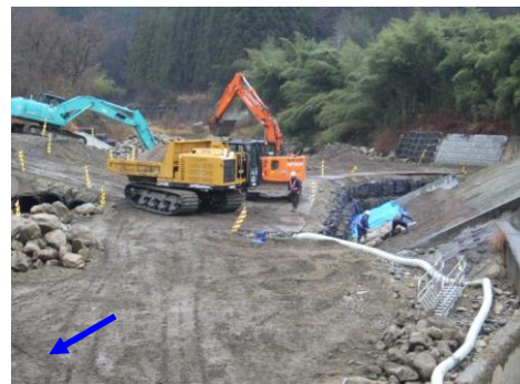
内川護岸工事の様子〈丸森町字滝原〉
