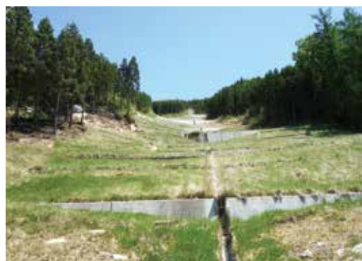
治山工事により復旧した廻倉地区
