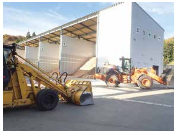
視察先：福島県田村市 「田村バイオマス発電所」では福島県産の未利用材を燃料として発電します。
