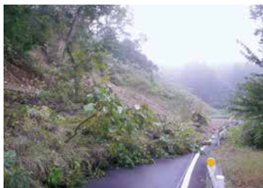
令和元年東日本台風災害の状況
