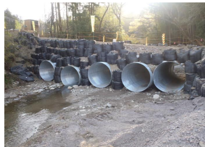
馬淵橋外災害復旧工事(仮設工事)
