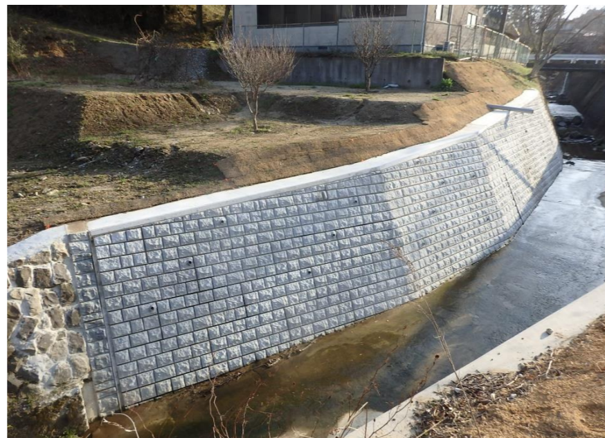
大蔵川(右岸) 護岸復旧工事
