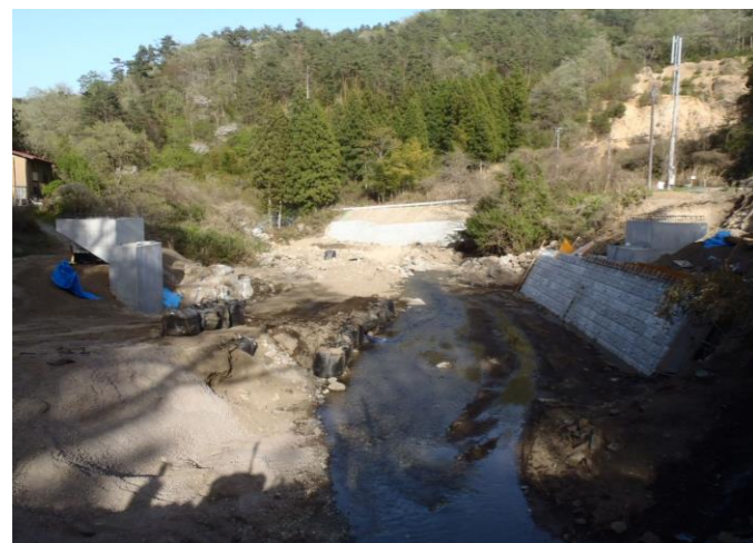
馬淵橋外災害復旧工事(全体写真) (R5年度未完了予定)
