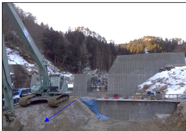
砂防堰堤工事（改築）の様子（字薄平）
