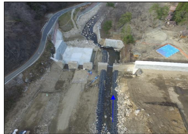
砂防堰堤工事（改築）の様子（字不動）
