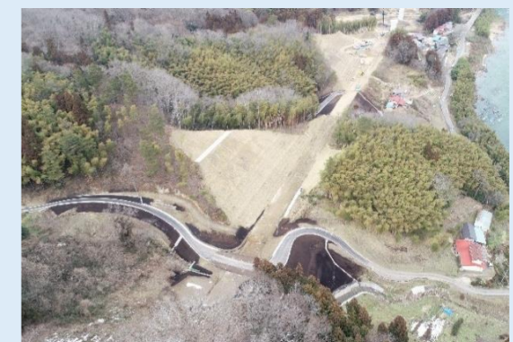
② 橋梁下部工施工中の様子
