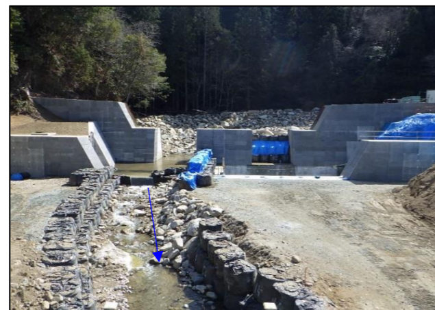
砂防堰堤工事（改築）の様子（字土ヶ森）
