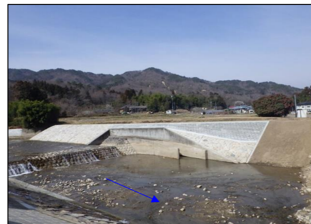
内川護岸工事完了後の様子（字滝原）
