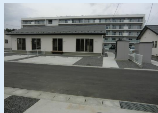
神明住宅(木造)建完成後の様子
