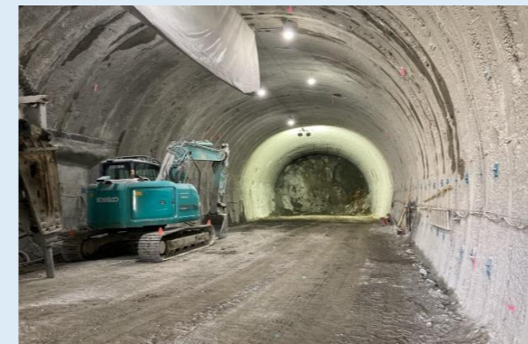
③ 3号トンネル掘削中の様子
