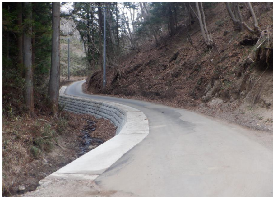
町道 井戸尻線 路肩復旧工事
