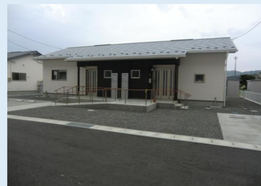
神明北住宅(木造)完成後の様子
