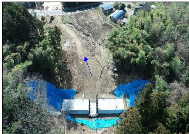
砂防堰堤工事（新築）の様子（字大畑）
