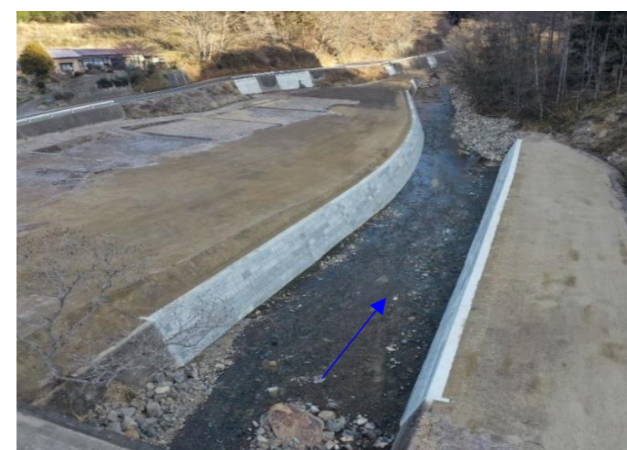
内川護岸工事完了後の様子（筆甫字川下一）
