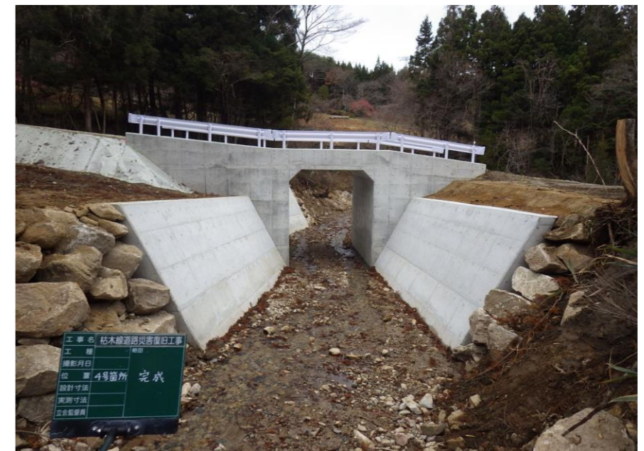
林道枯木線4号箇所 災害復旧工事
