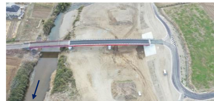
中平橋設置工事(完成：大内字石神)
