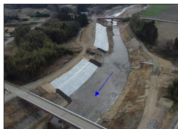
内川護岸工事の様子（字前河原）
