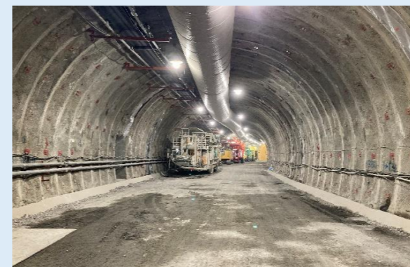
① 1号トンネル掘削中の様子
