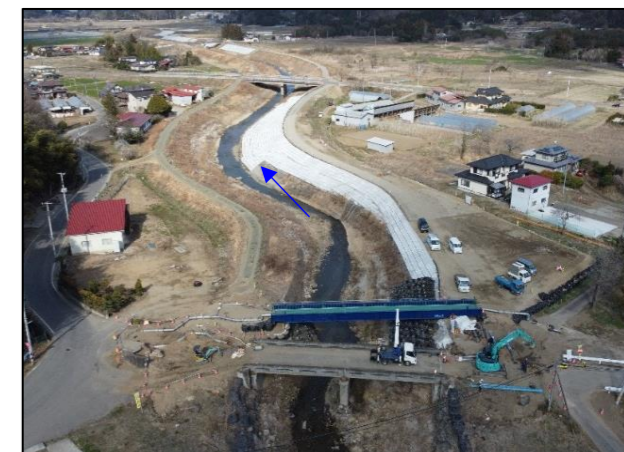
五福谷川水道仮橋工事の様子（字塚田）
