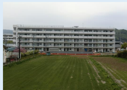
神明北住宅(RC造)建設工事の様子
