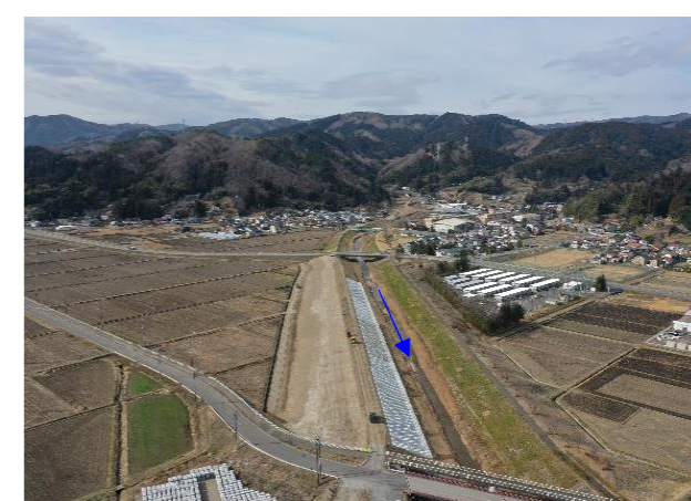
新川築堤工事の様子（字土橋）
