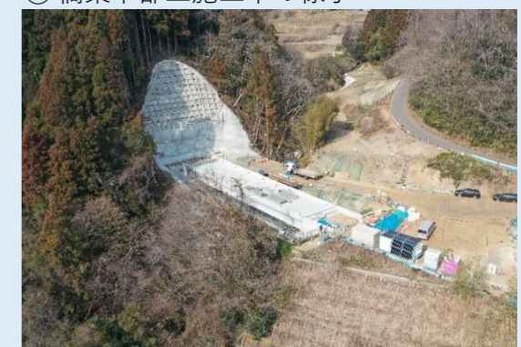
④ 橋梁上部工施工中の様子
