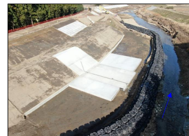
内川山下堰工事の様子（字上林東）
