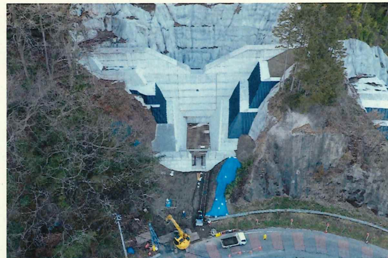
流路工 (床固め、擦付護岸工)
