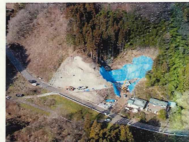
⑯原場砂防堰堤 管理用道路 法面工 吹付枠設置 〈原場砂防堰堤 上空〉
