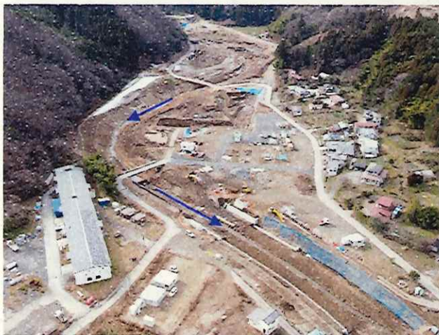
⑧-1五福谷川遊砂地 流路工 流路掘削 〈五福谷川遊砂地 下流〉
