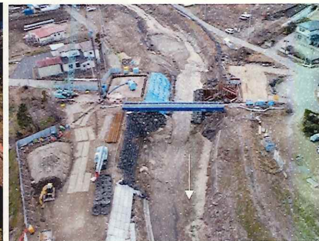
旧五福谷川橋 旧橋撤去工 施工中 〈旧五福谷橋上流〉
