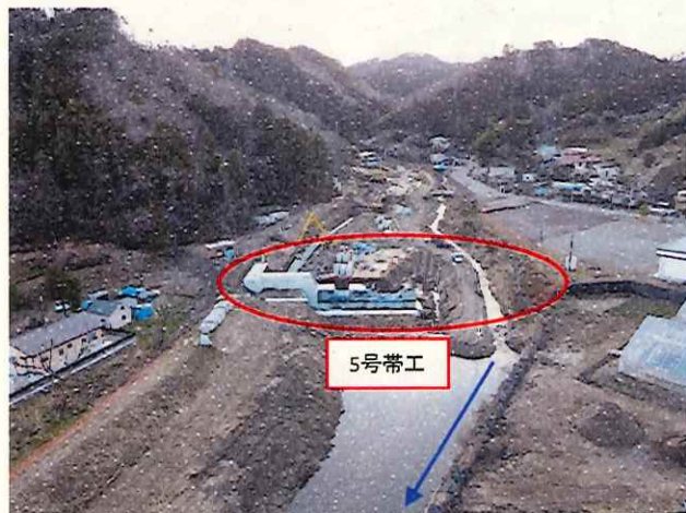
⑰-1新川遊砂地 5号帯工 型枠組立・コンクリート打設 〈新川遊砂地 下流〉
