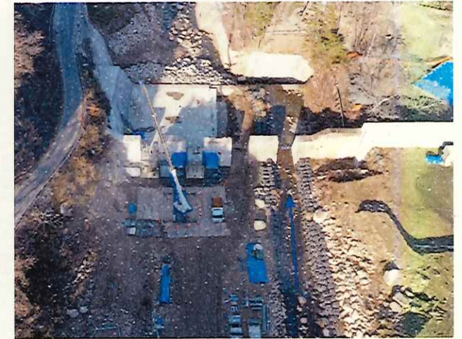
④不動尊砂防堰堤 型枠組立・コンクリート打設 〈不動尊砂防堰堤 上空〉
