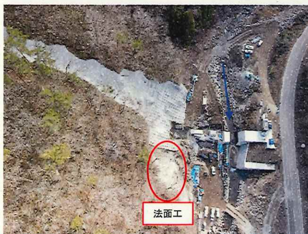
⑭薄平砂防堰堤 法面工 フレーム組立 主堰堤 差筋削工 〈薄平砂防堰堤 上空〉
