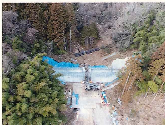
⑳大畑沢砂防堰堤 型枠組立・コンクリート打設 〈大畑沢砂防堰堤 上空〉
