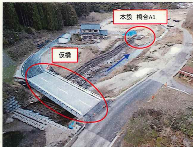
⑧-2岩下橋下部工 仮橋架設完了 〈岩下橋 上流〉
