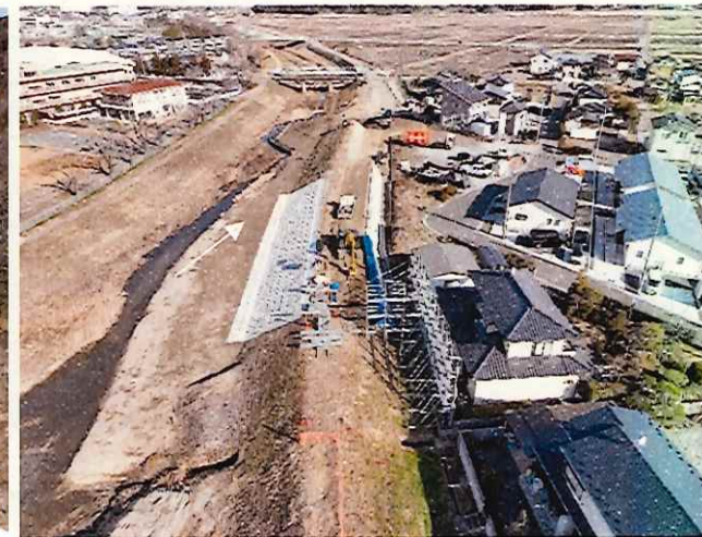
新川 河川土工 施工中 〈泉橋上流〉
