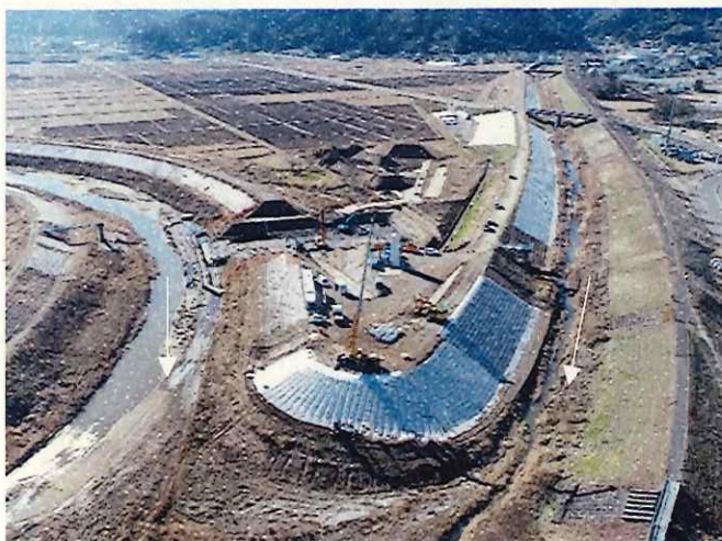
樋管③ 樋管本体工 施工中 〈内川・新川合流点〉
