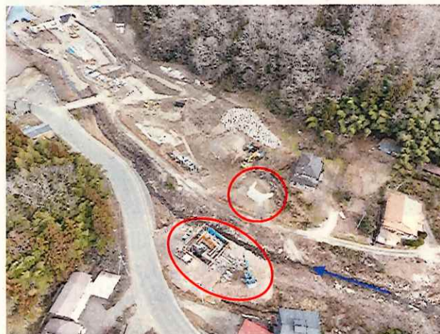
⑰-2飯塚橋下部工 型枠組立・コンクリート打設 〈飯塚橋 上空〉
