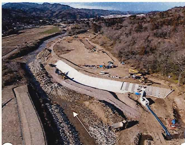
内川 法覆護岸工・導水路工 施工中 〈矢田橋上流〉
