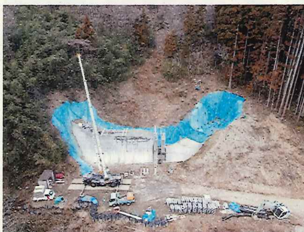
⑮下北山砂防堰堤 型枠組立・コンクリート打設 〈下北山砂防堰堤 上空〉
