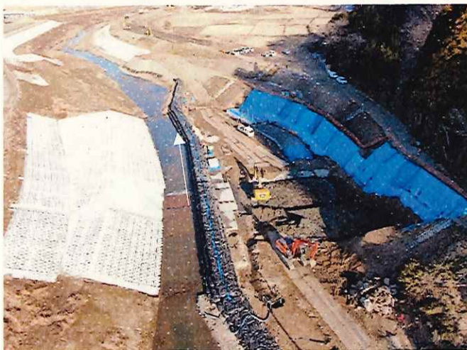
内川流域山下堰 山下堰(右岸) 仮設工 施工中 〈大目橋下流〉
