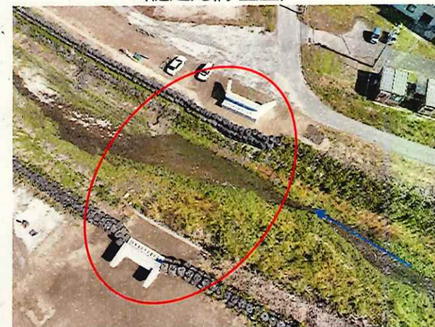
⑧-3樋之元橋下部工 橋台完成 〈樋之元橋 上空〉
