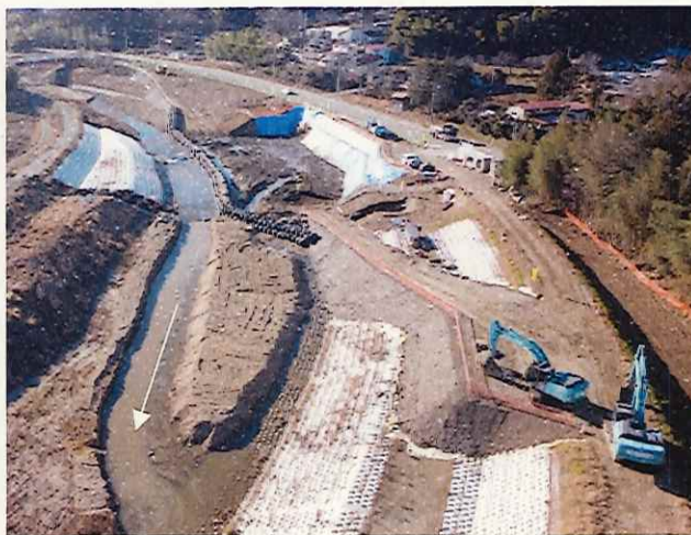
内川流域和田堰 (左岸) 和田堰(左岸) 構造物撤去工 施工中 〈和田橋下流〉
