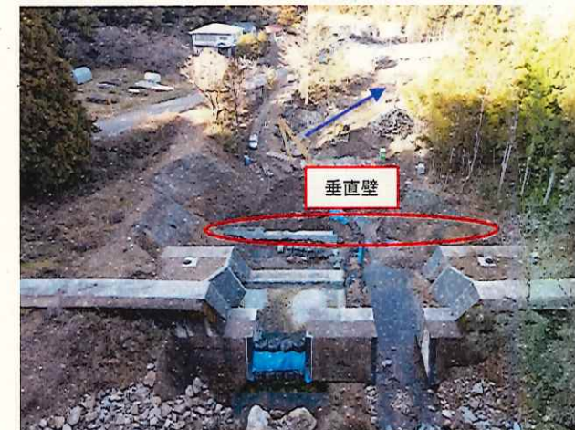
⑱土ヶ森砂防堰堤 垂直壁 型枠組立・コンクリート打設 〈土ヶ森砂防堰堤 上流〉
