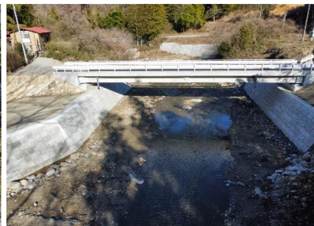
馬淵橋梁完成の様子(丸森地区)
