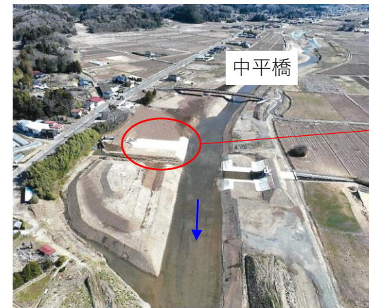
排水樋門工事(その2)の様子(中平橋付近)
