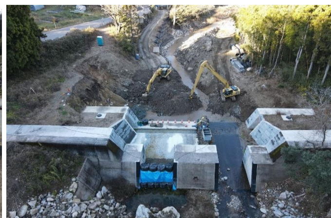
砂防堰堤工事（改築）の様子（字土ヶ森）
