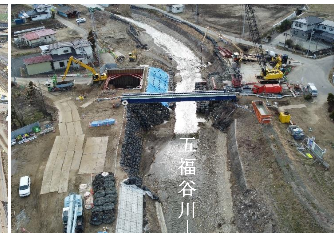
旧五福谷橋 旧橋撤去の様子（字塚田）
