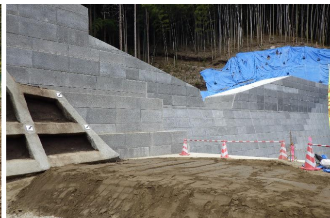
砂防堰堤工事（新築）の様子（字原場）
