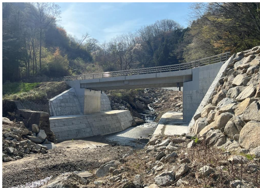
落合橋(町道五福谷北山線)工事完了後の様子（丸森地区）
