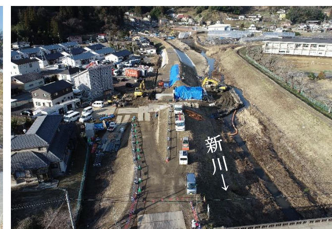
新川樋管工事の様子（字飯泉）
