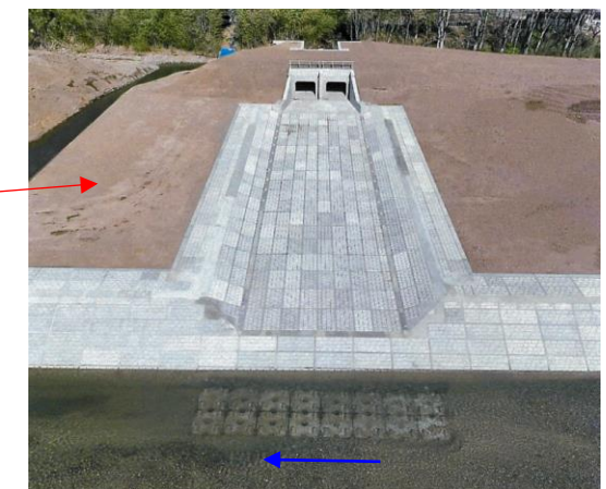
排水樋門工事(その2)の様子(拡大)
