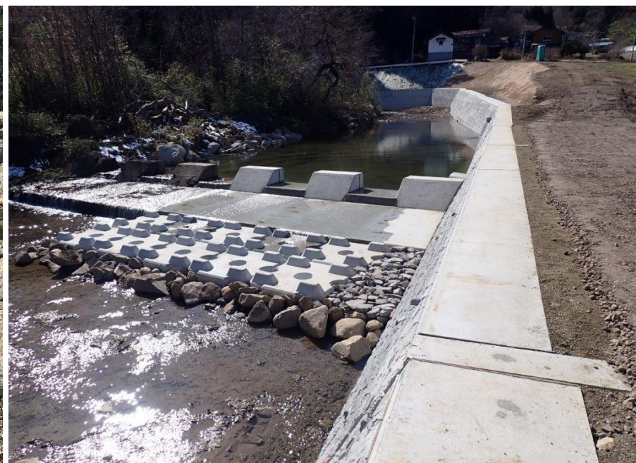
鷲ノ平区頭首工工事完了後の様子（筆甫地区）
