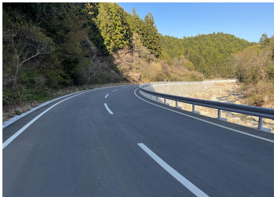
町道五福谷北山線工事完了後の様子（丸森地区）
