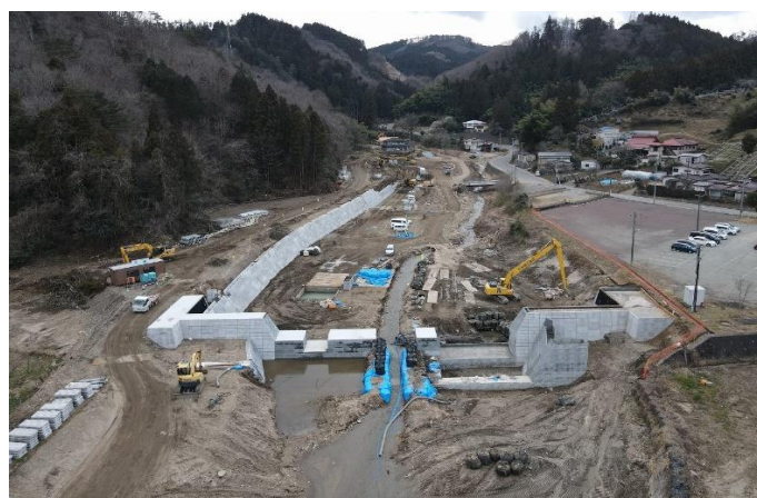
遊砂地工事の様子（字虚空蔵下）
