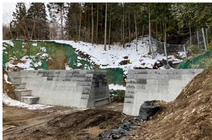
砂防堰堤工事（新築）の様子（筆甫字川下三）
