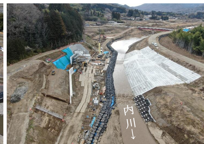
内川山下堰工事の様子（字上林東）
