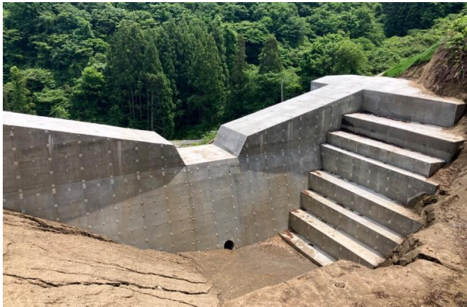
砂防堰堤工事（新築）の様子（宇原場）
