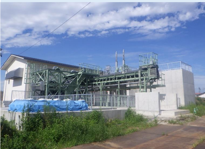
新設雨水ポンプ場建屋の様子
