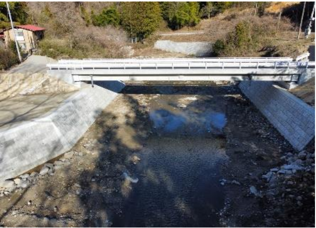
馬淵橋梁完成の様子（丸森地区）
