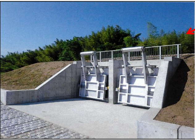
雉子尾川排水樋門ゲート工事完了の様子（拡大）
