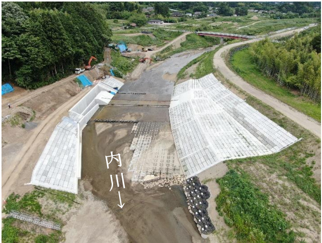
内川山下堰工事の様子（字上林東）
