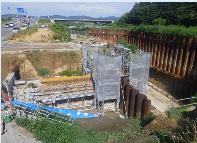
新設雨水ポンプ場放流渠の様子
