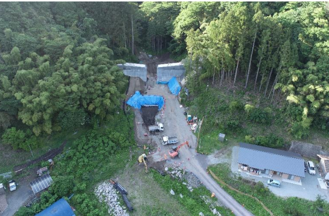
砂防堰堤工事（新築）の様子（宇大畑）
