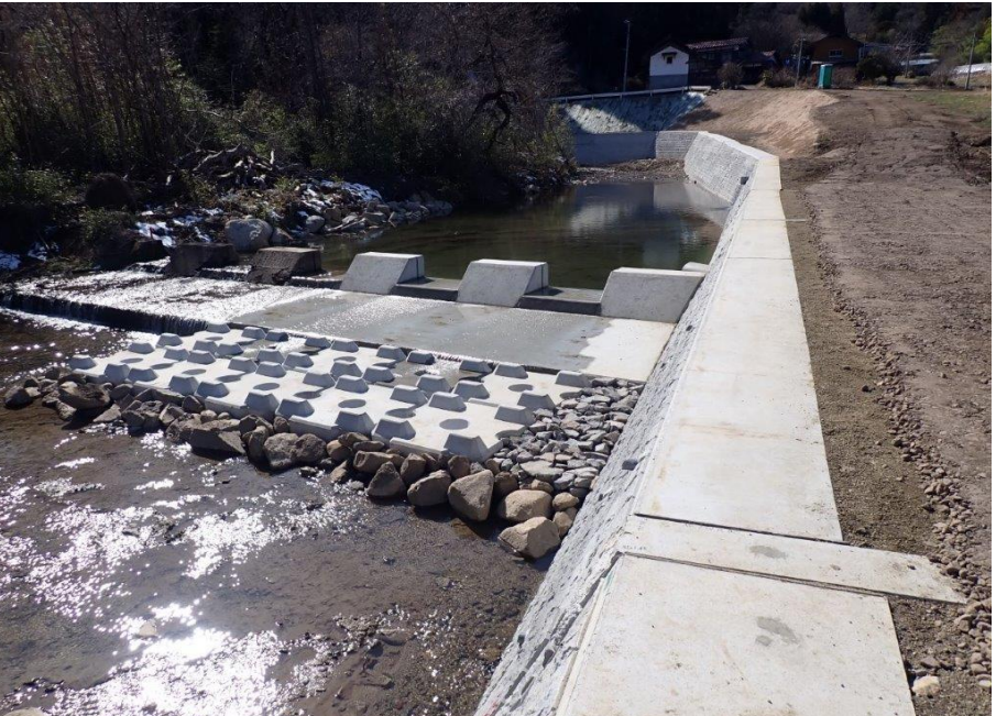
鷺ノ平区頭首工工事完了後の様子（筆甫地区）
