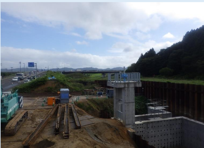
新設雨水ポンプ場放流渠の様子
