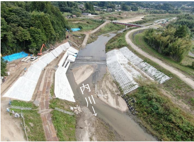
内川山下堰工事の様子（字上林東）
