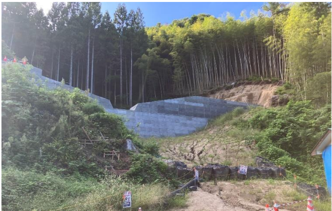
砂防堰堤工事（新築）の様子（字原場）
