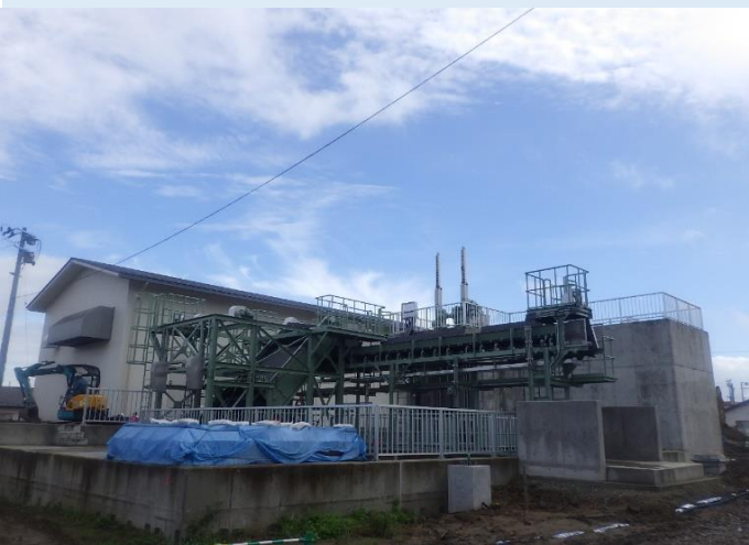
新設雨水ポンプ場建屋の様子
