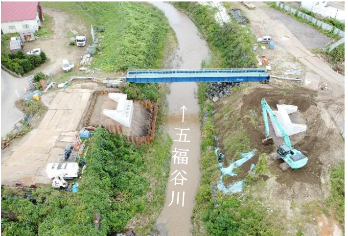
旧五福谷橋 旧橋撤去の様子（字塚田）
