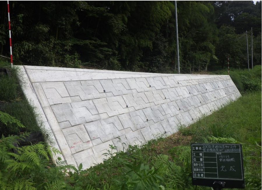
町道宮ノ田福田線工事完了後の様子（耕野地区）
