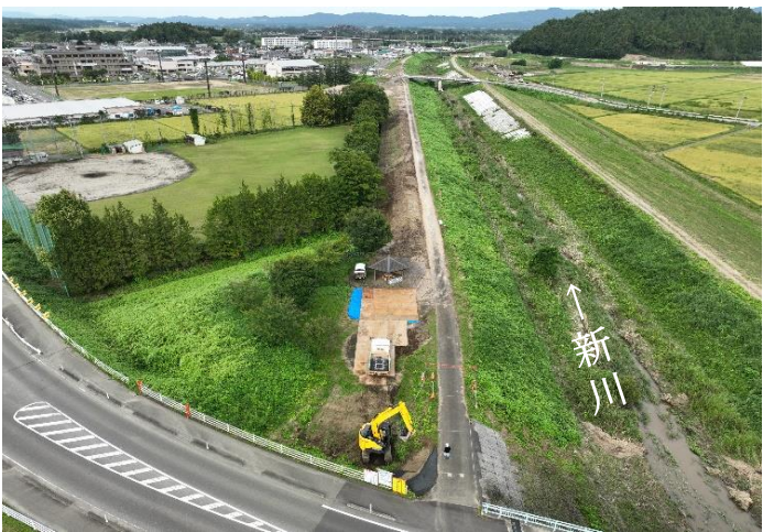
新川左岸築堤工事の様子（字雁歌）
