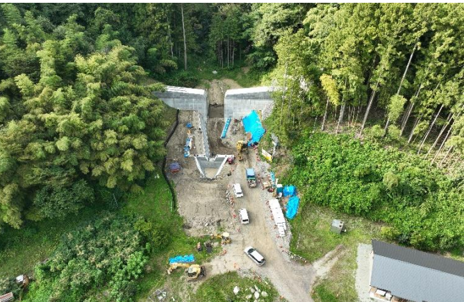
砂防堰堤工事（新築）の様子（字大畑）
