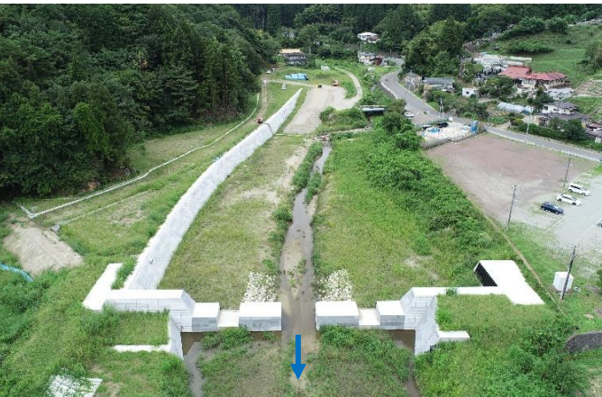
遊砂地工事の様子（字虚空蔵下）
