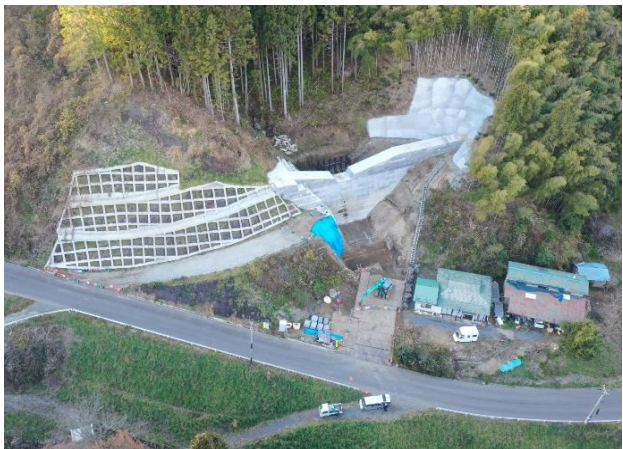
砂防堰堤工事（新築）の様子（宇原場）
