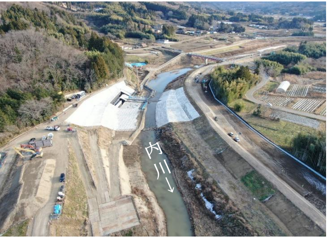
内川山下堰工事の様子（字上林東）
