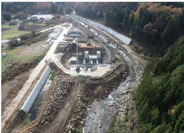
内川遊砂地工事の様子（宇石羽）
