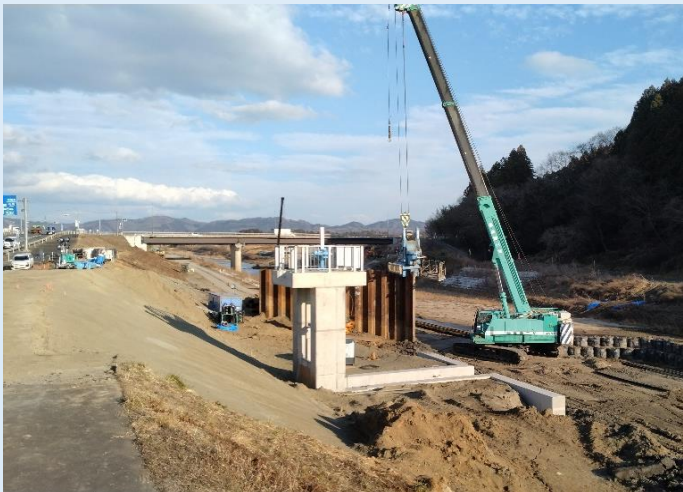
新設雨水ポンプ場放流渠の様子
