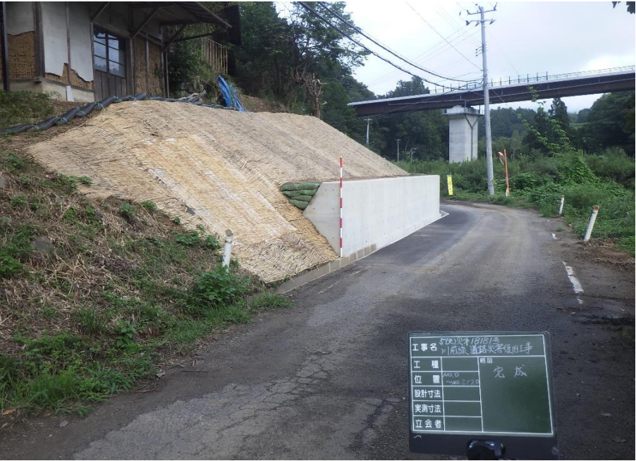
町道川前線工事完了後の様子（耕野地区）
