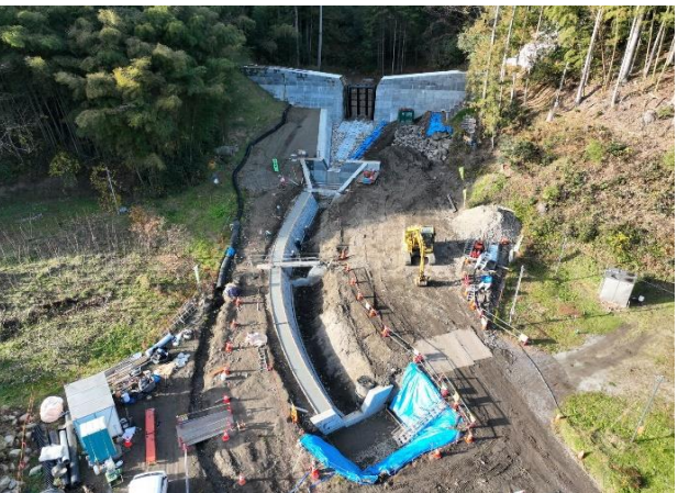
砂防堰堤工事（新築）の様子（宇大畑）
