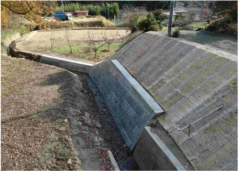
美録地区水路工事完了後の様子（大張地区）
