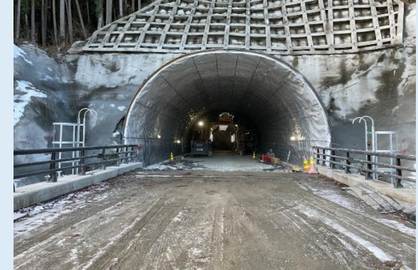
④ (仮) 3号トンネル終点側杭口の様子
