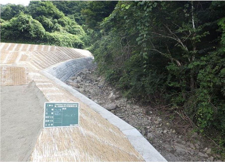
廻倉地区水路工事完了後の様子（丸森地区）
