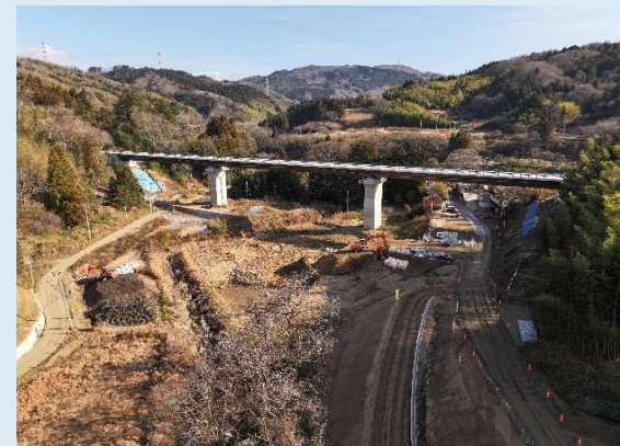
① (仮)第1号橋工事の様子（八島工業(株)付近）
