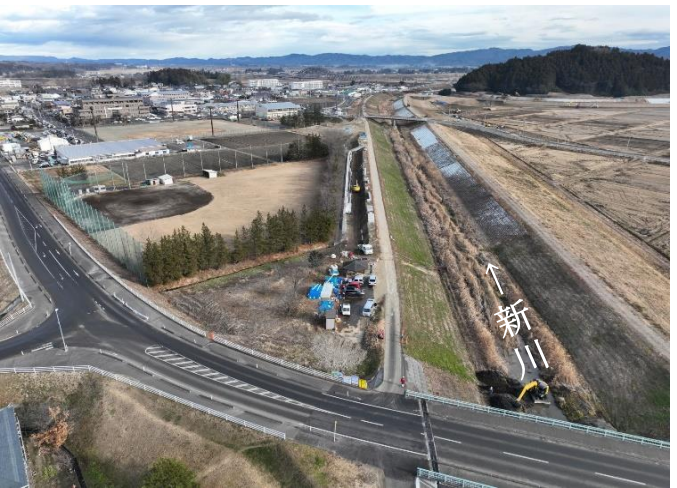
新川左岸築堤工事の様子（字雁歌）
