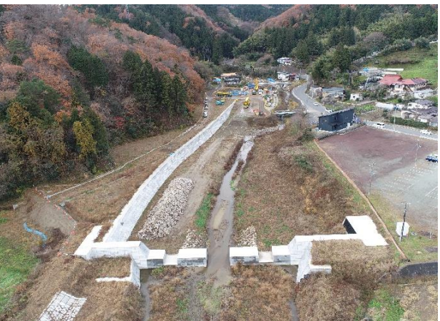
新川遊砂地工事の様子（宇虚空蔵下）
