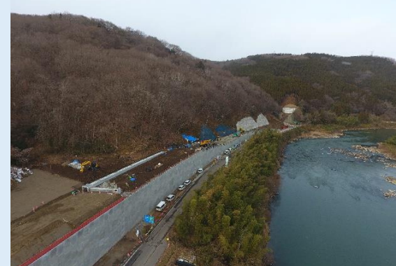
③ 県境付近道路改良工事の様子
