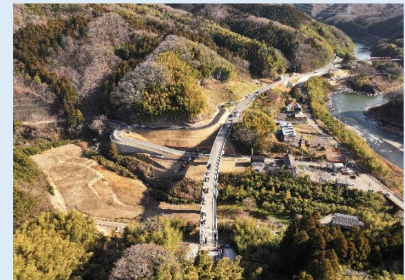
② (仮)第2号橋工事の様子（やしまや付近）
