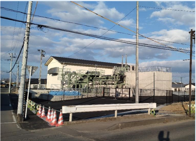
新設雨水ポンプ場建屋の様子
