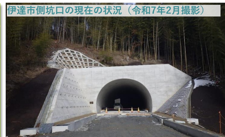
耕野火石坂トンネル②
