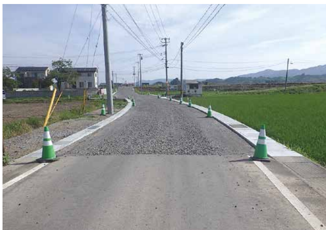
整備がすすむ町道中原線（小斎地区）
