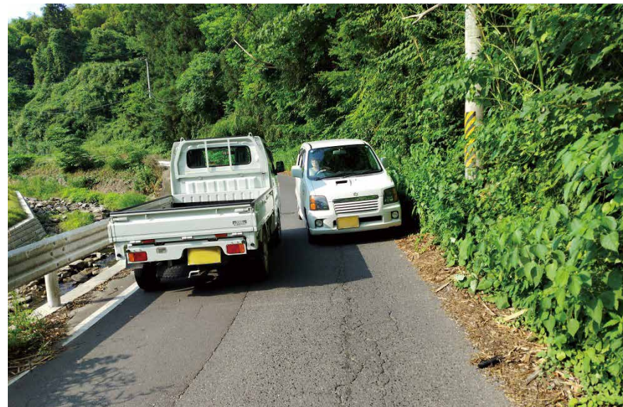
軽自動車の交差もままならない未改良県道（大張三河尻地区）
