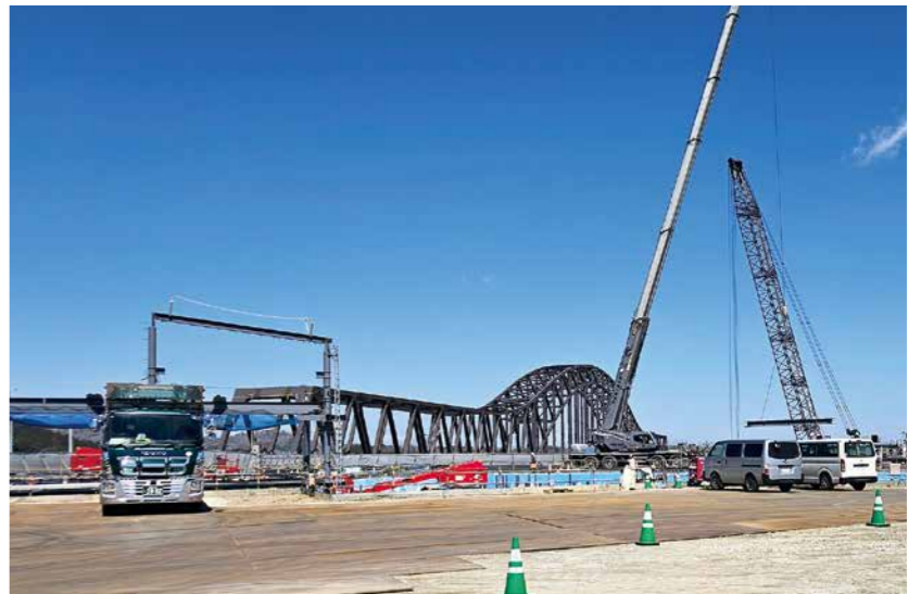
着々と工事が進むMIZBEステーション
