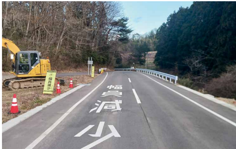
本町分の改良工事が完了した白石丸森線（大張地区）
