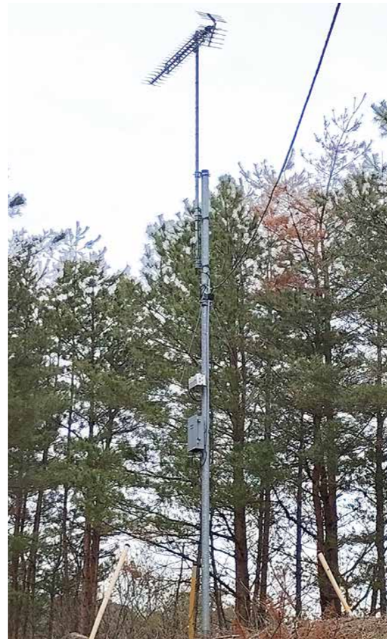
維持管理が大変、山中にある共聴アンテナ
