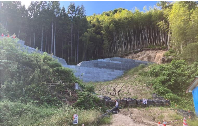
砂防堰堤工事（新築）の様子（字原場）
