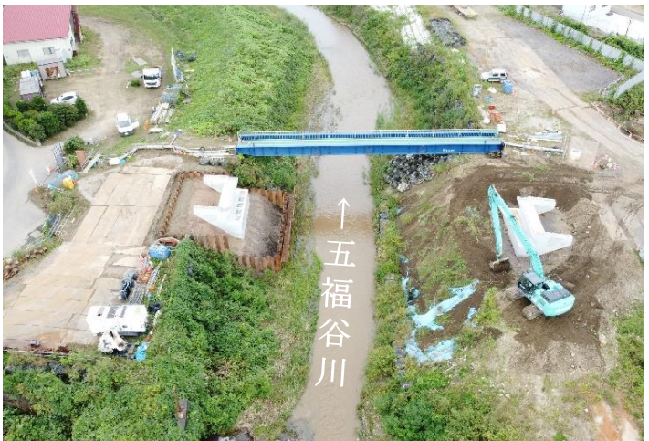
旧五福谷橋 旧橋撤去の様子（字塚田）
