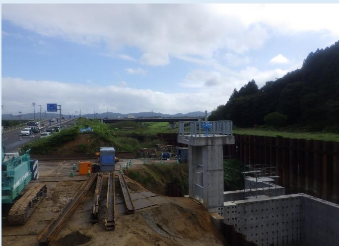
新設雨水ポンプ場放流渠の様子
