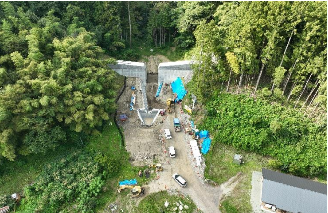
砂防堰堤工事（新築）の様子（字大畑）
