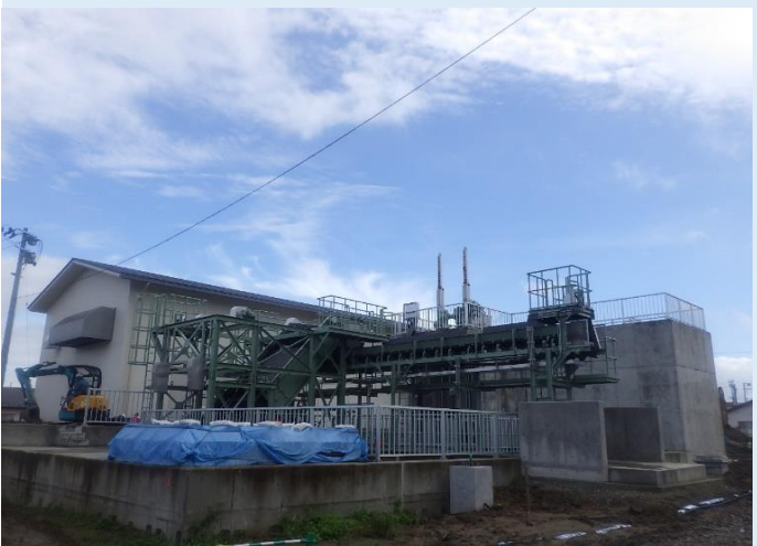
新設雨水ポンプ場建屋の様子
