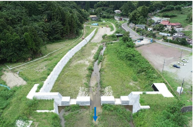
遊砂地工事の様子（字虚空蔵下）
