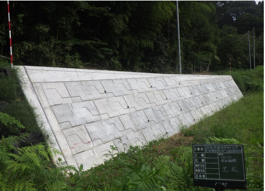
町道宮ノ田福田線工事完了後の様子（耕野地区）
