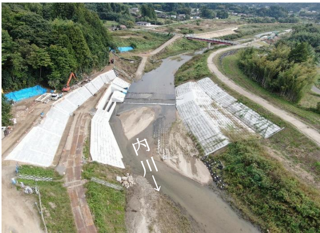
内川山下堰工事の様子（字上林東）
