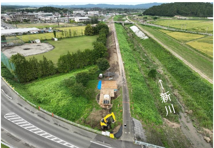
新川左岸築堤工事の様子（字雁歌）
